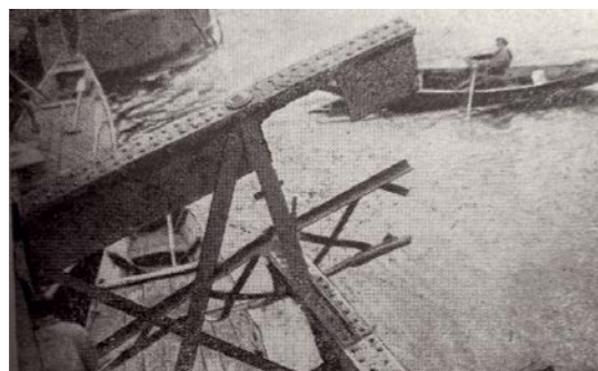
Фрагмент пролета бывшего Николаевского цепного моста
