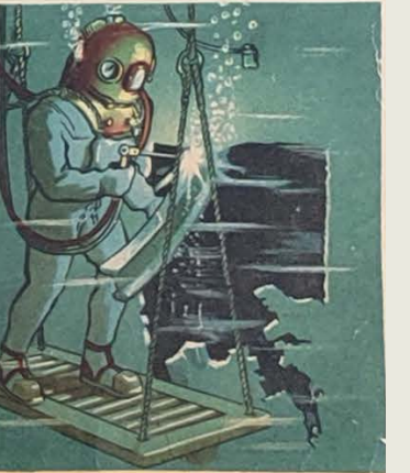
Электрокислородная резка
