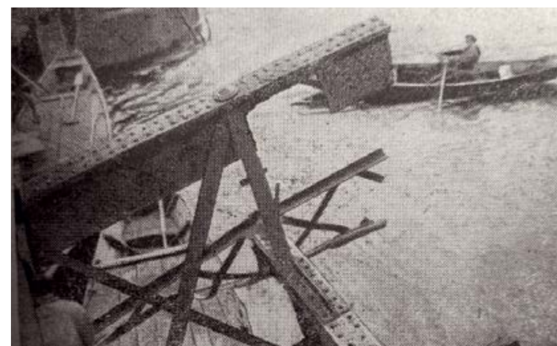
Фрагмент пролета бывшего Николаевского цепного моста
