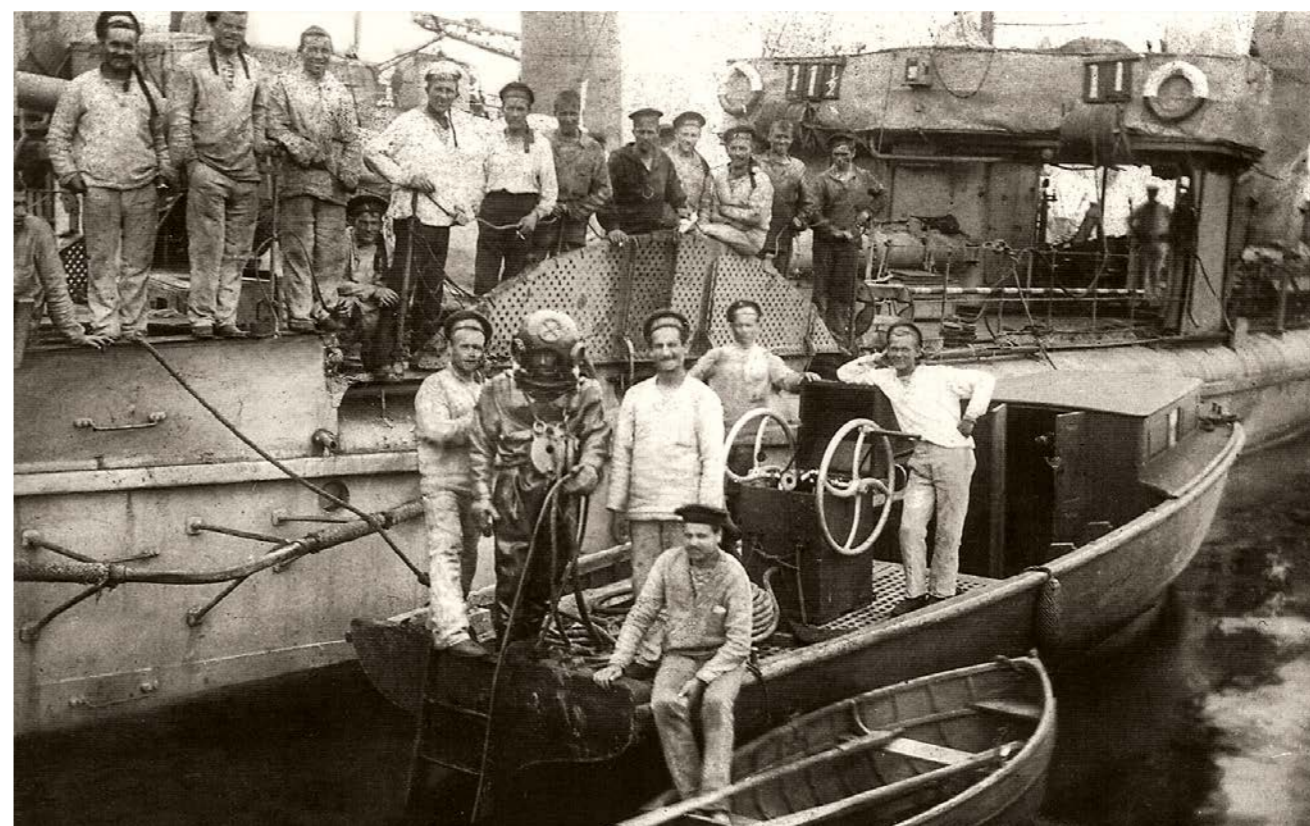
▲ Водолазные работы по бездоковому ремонту корпуса миноносца, 1917 г.
