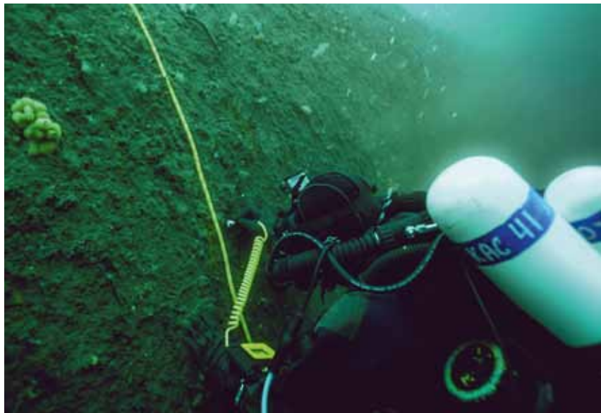
Глубина 25 метров. Замер толщины металла на легком корпусе
