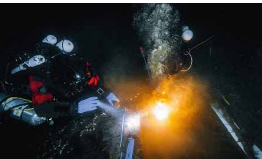
Глубина 23 метра. Экзотермическая резка корпусных конструкций
