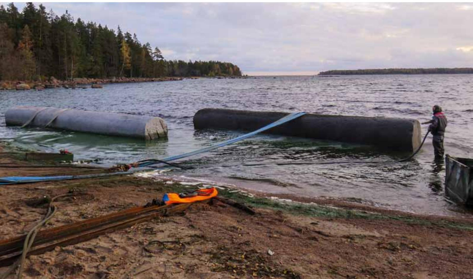
Очистка колонны с помощью пескоструйной установки началась, когда часть ее еще находилась в воде
