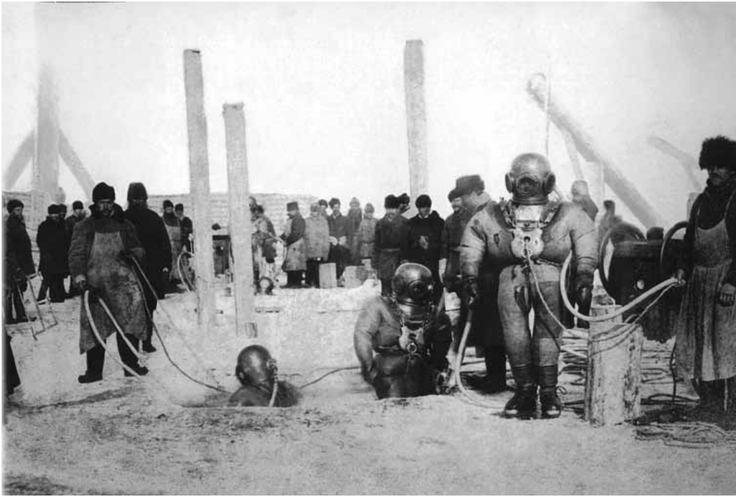
1896 год. Обследование дна при строительстве моста через р. Енисей. Фотография из фондов Музея истории Красноярской железной дороги
