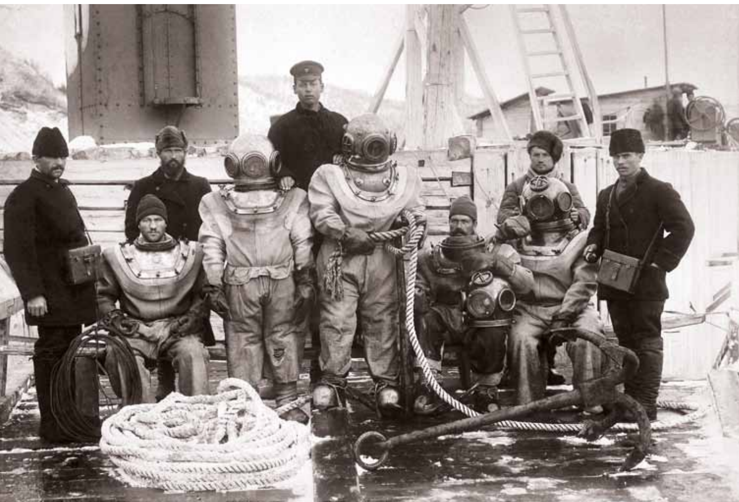
1895–1900 годы. На строительстве Забайкальской железной дороги
