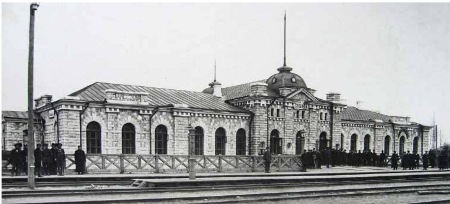
Слюдянка, железнодорожная станция
