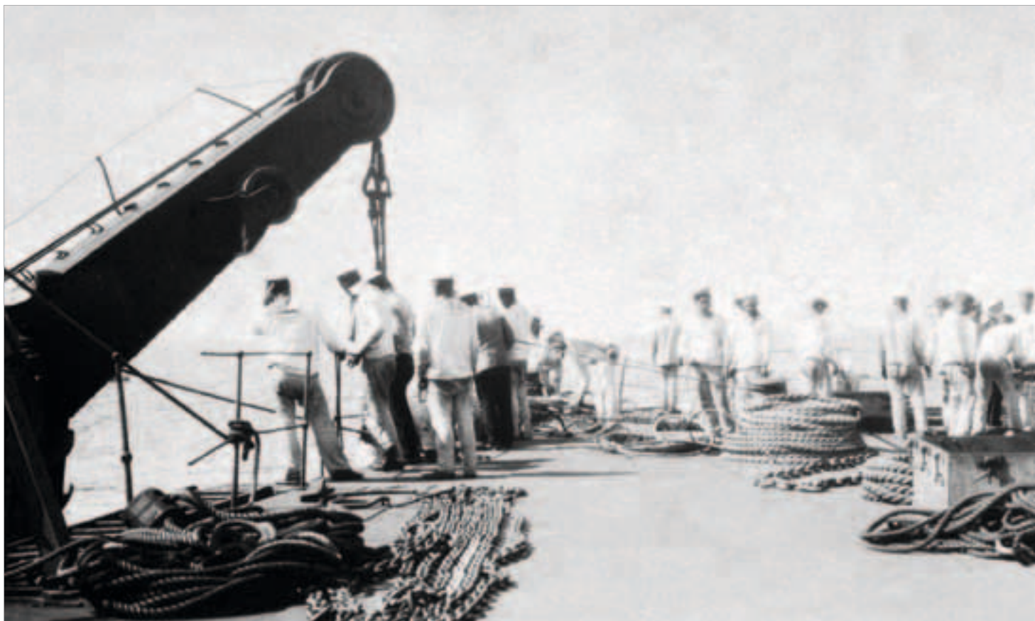
Плашкоут, использовавшийся при подъеме «Камбалы», был по существу просто понтоном и не имел на борту грузоподъемных средств. Поэтому для обтяжки судоподъемных стропов использовался килектор
