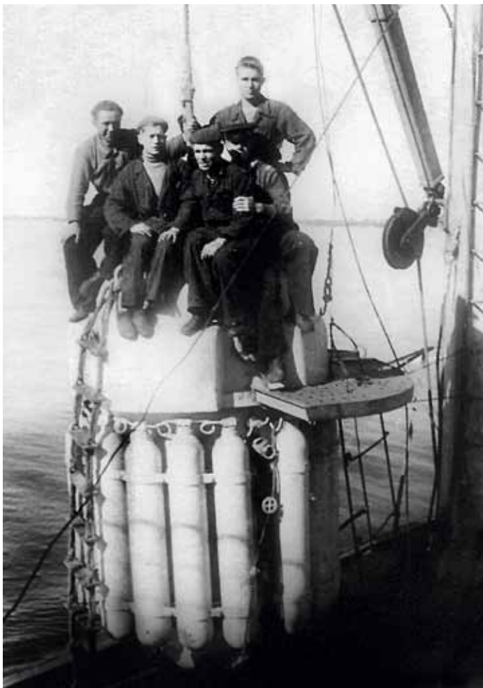
Водолазный колокол «закрытого» типа разработки А.З. Каплановского начала 1940-х годов. Отличительная особенность колокола — верхняя стыковка с палубной декомпрессионной камерой
