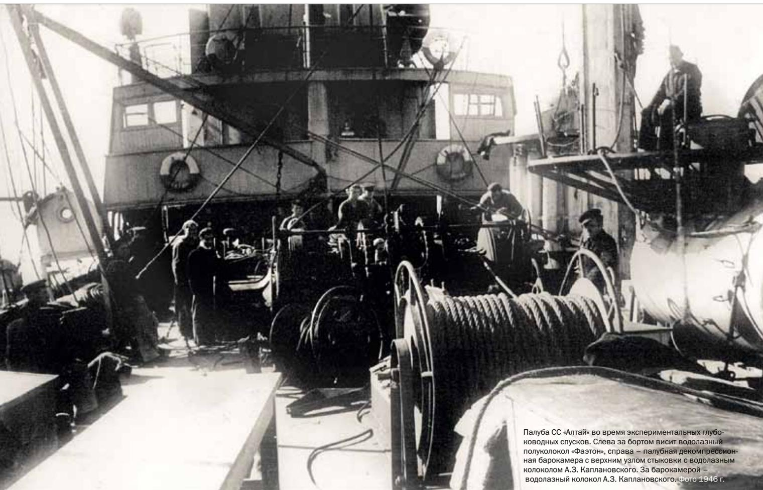
Палуба СС «Алтай» во время экспериментальных глубоководных спусков. Слева за бортом висит водолазный полуколокол «Фазтон», справа – палубная декомпрессионная барокамера с верхним узлом стыковки с водолазным колоколом А.З. Каплановского. За барокамерой – водолазный колокол А.З. Каплановского. Фото 1946 г.
