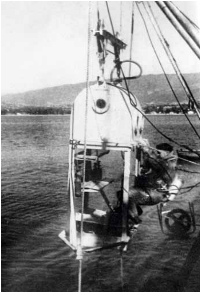
Водолазный полуколокол «Фазтон», с помощью которого была выполнена большая часть глубоководных водолазных погружений в первые послевоенные годы. Фото 1946 г.
