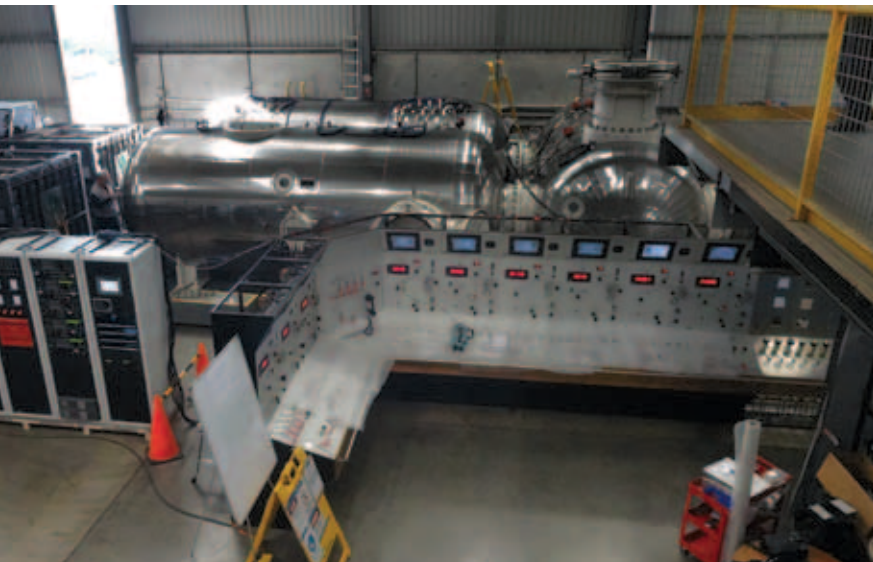
Рис. 3. Центральный пульт управления комплексом в процессе сборки
